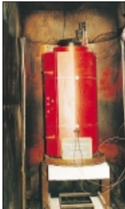
Испытание F1 на катушке в сборе трансформатора Trihal
